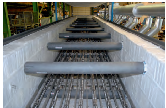
Bild 2: Blick in den Ofenraum
